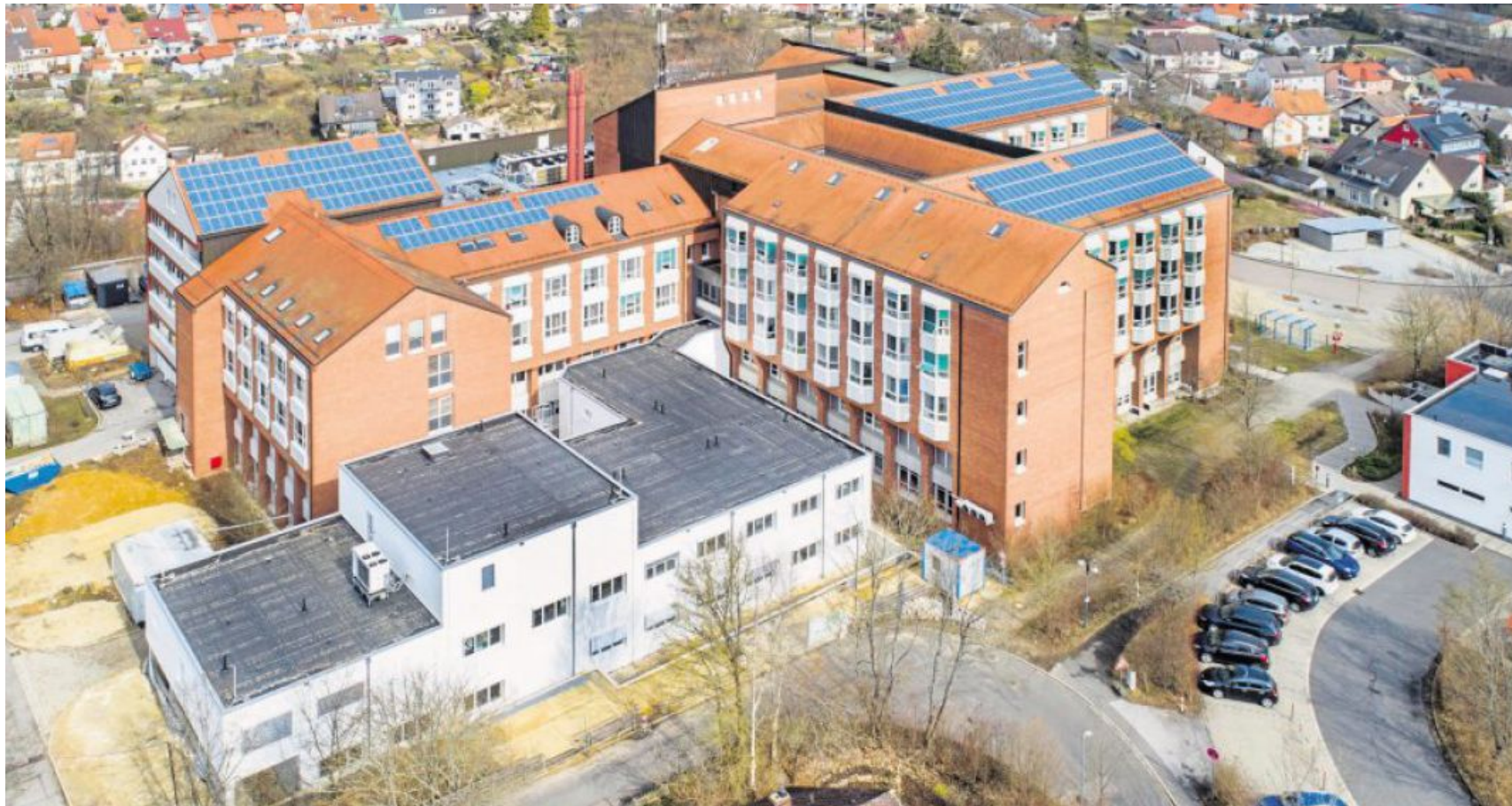
Für die Intensivstation und Physiotherapie ließ das St.-Anna-Krankenhaus 35 Raummodule (vorne, links) an das Hauptgebäude anbauen.
