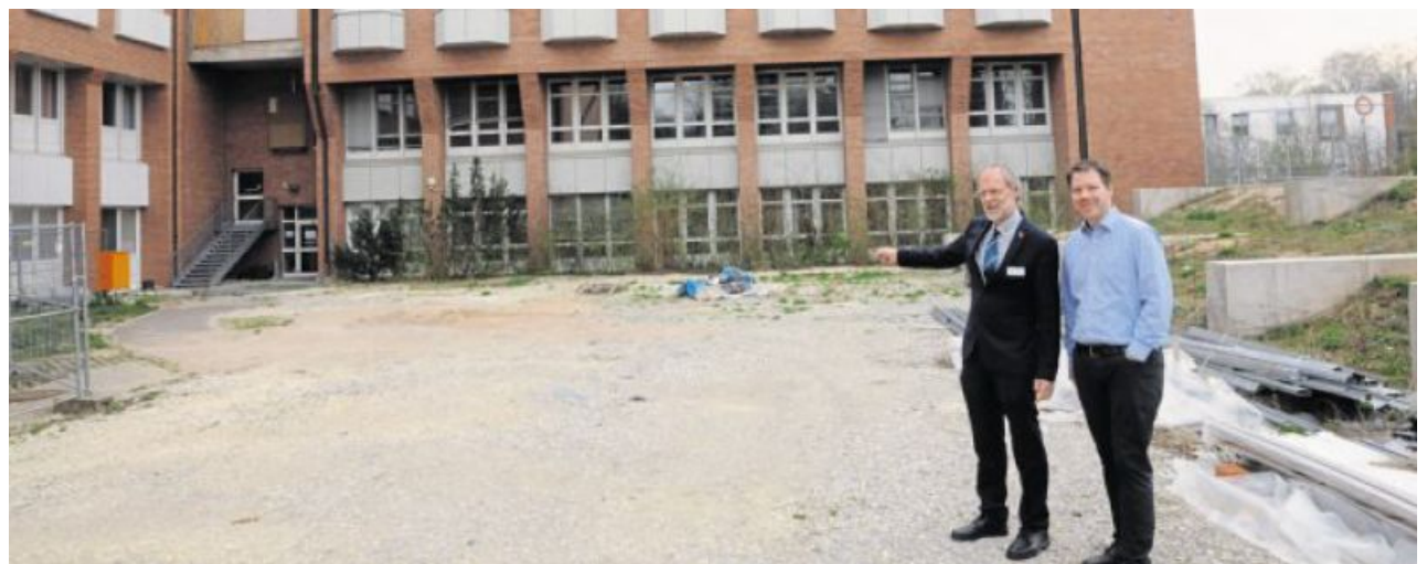
Vorstand Klaus Emmerich (links) und Vorstandsreferent Andreas Poeplau zeigen, wo die Zwischenlösung für die Küche hinkommt. Hier im Westen des Komplexes werden im Sommer wieder Container aufgestellt.
