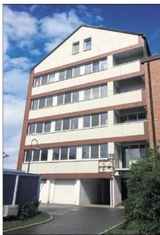
Der älteste Gebäudetrakt im Krankenhauskomplex wird abgerissen.
